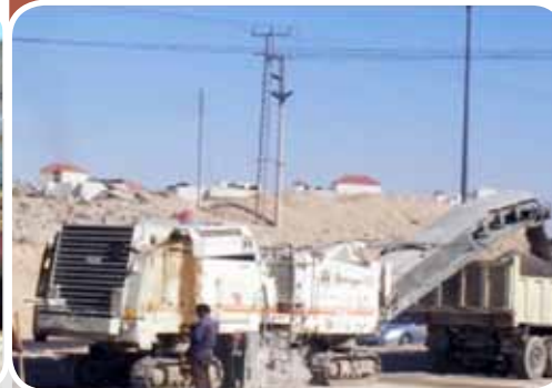
قاشطة اسفلت (٢) Asphalt Milling (2)
